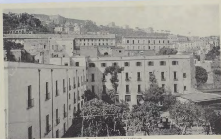
Facciata interna dell'Istituto
