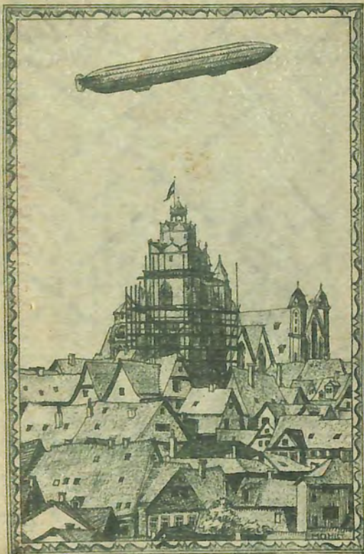
Zeppelin über Wetzlar, Sept. 1909 Dort, zur Zeit der Instandsetzung, ist zum Teil noch mit Baugerüst umgeben. AUFNAHME N. BEFORT ZEICHNUNG HUGO MÖHL
