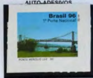
Ponte Hercílio Luz-SC 2304
