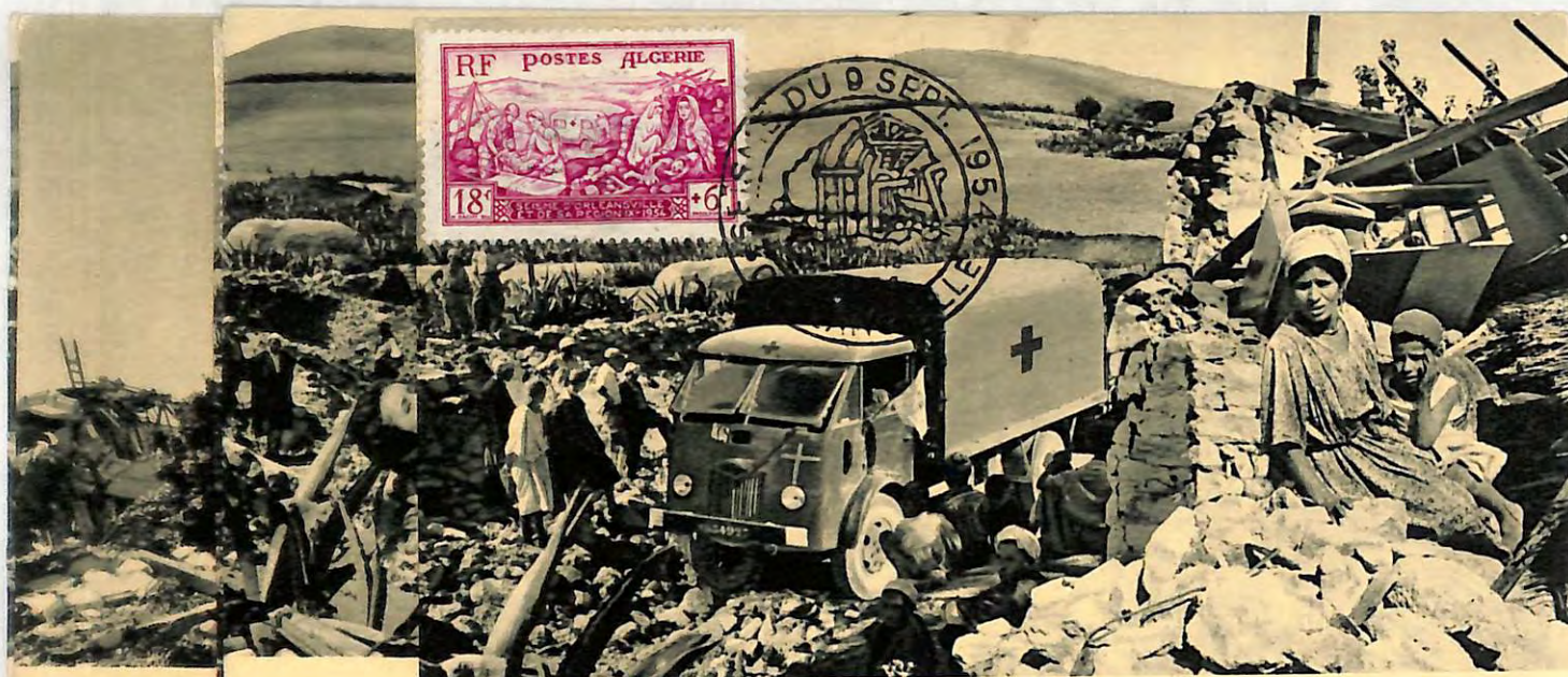
Région d'ORLÉANSVILLE après le séisme.
