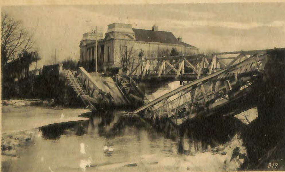
Vom östlichen Kriegsschauplatz. Mitau. Die von den Russen gesprengte Brücke über die Drixe, nebenan die neue deutsche Notbrücke
