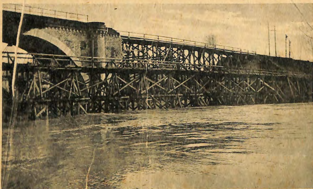
An der Aisne Vorn Kolonnenbrücke Plonier-Batl. 21. Dahinter Eisenbahnbrücke Eisenbahn-Bau-Komp. 17
